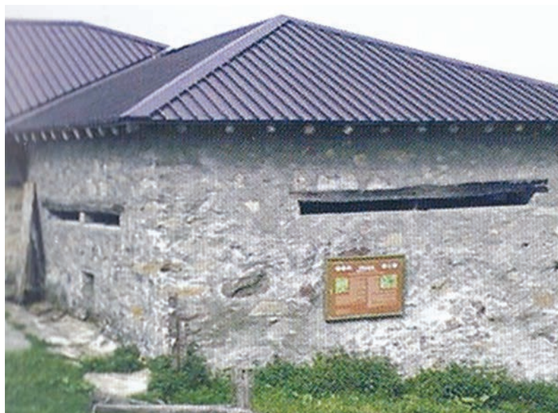
Malga Pianazzo: finestre orizzontali per l'aerazione del deposito del latte.
